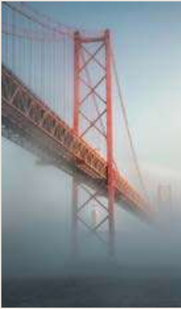
Pont du 25 avril
